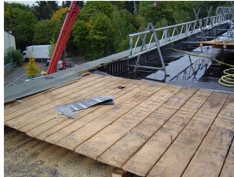
Aus „praktischen“ Erwägungen wurden zusätzlich Gitterträger, aufgeständert auf jeweils zwei Gerüstrohren, erst als Absperrungen in ausreichendem Abstand, dann als Absturzsicherungen direkt an der Attika aufgestellt, die mit den zugelassenen transportablen Flachdach-Sicherungen verbunden werden sollten (Planung/Anweisung Dachdecker).
