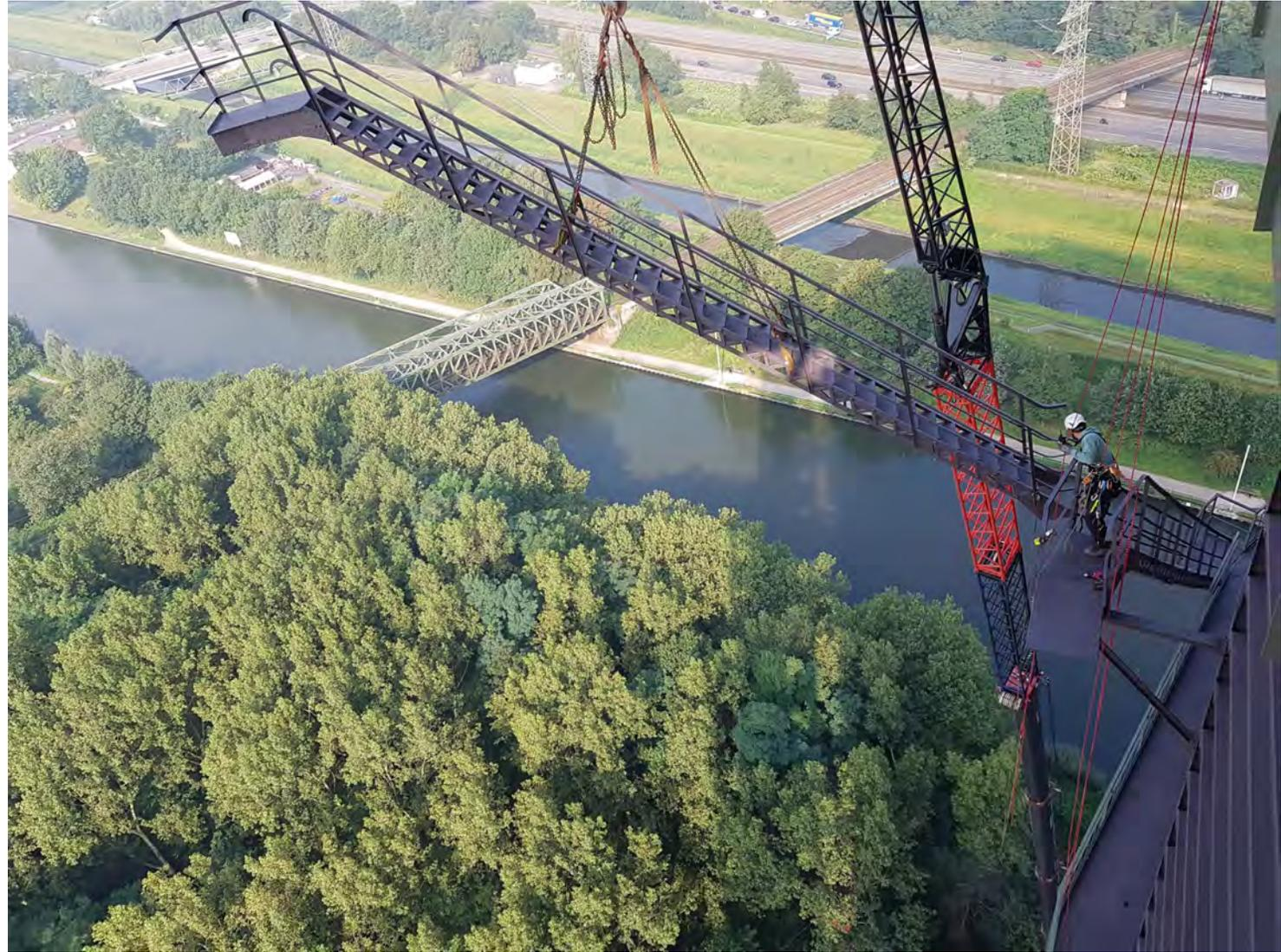
Nach der Sanierung der Außentreppe passten manchmal die oberen Treppe nicht mit der unteren Treppe
